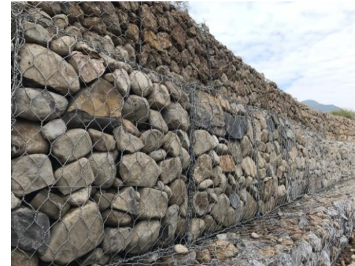
Fotografía 24 Empleo de gaviones con malla electrosoldada
