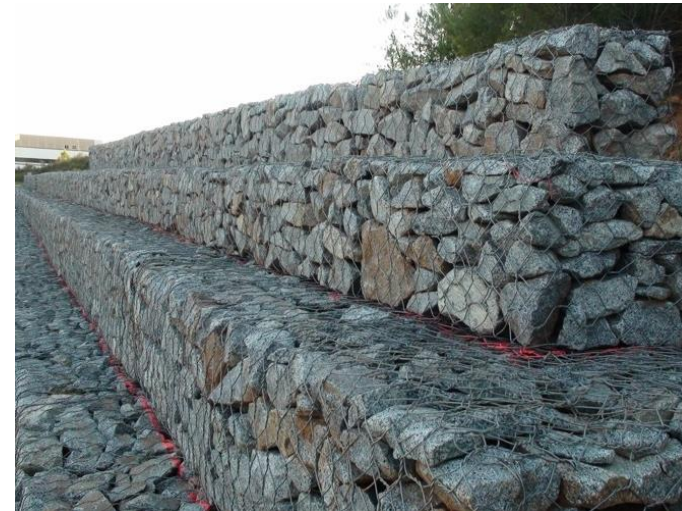
Fotografía 9 Graderío con gaviones
