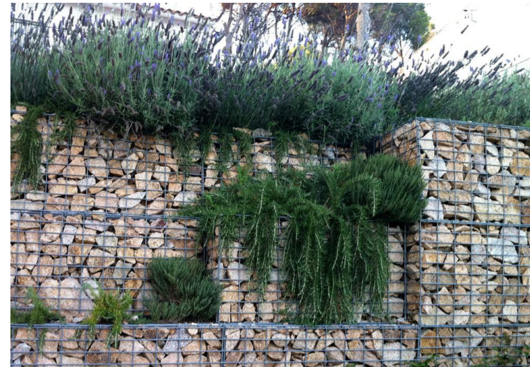
Fotografía 8 Implementación de muros de gaviones verdes
